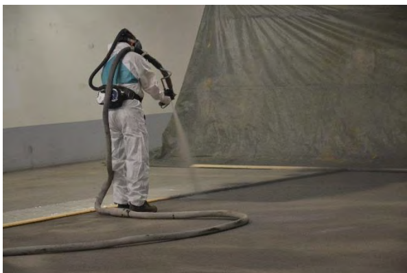
Figur 2.33 Sprutapplicering av polyurea genomförs (Foto: Y Edwards)
