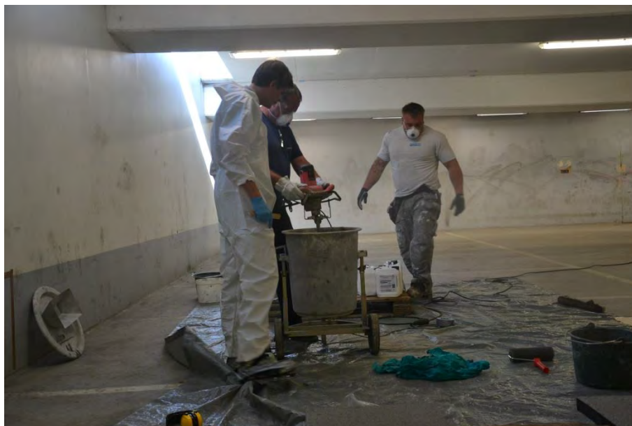
Figur 2.5 Blandning av hårdbetong Intercrete 4852 (Foto: Y Edwards)
