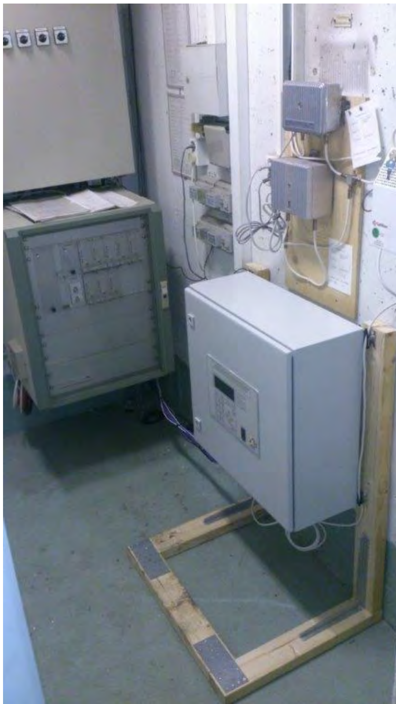
Figur 3.19 Ett nytt skåp har monterats av 3 C. Kablar har dragits från det gamla skåpet (det vänstra) till de nya skåpet (de högra). Idag är det möjligt att kontinuerligt kontrollera skyddsförmågan genom datorövervakning
