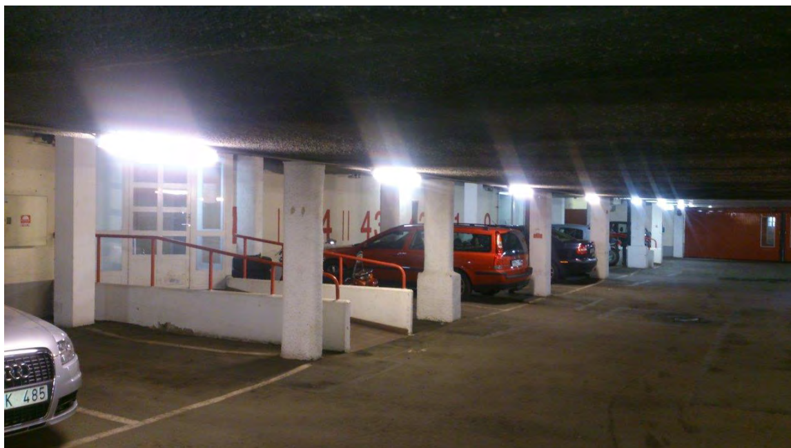
Figur 3.8 Parkeringsgarage, Smyckeparken 66-68, Göteborg. Taket och pelarana i Garaget är katodiskt skyddade med titannät
