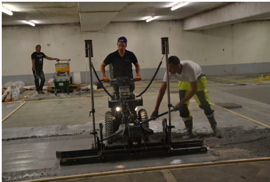
Figur 2.30 Laserläggningsmaskinen tar vid (Foto: Y Edwards)
