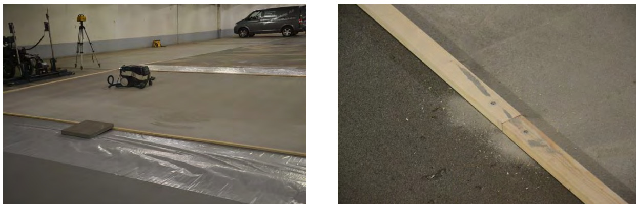
Figur 2.28 Inramad provyta inför utläggning av 20 mm Mastertop hårdbetong (Foto: Y Edwards)
