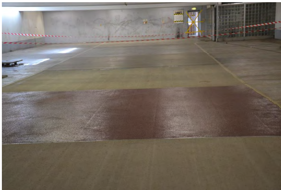
Figur 2.18 Färdig membranbeläggning (Foto: Y Edwards)
