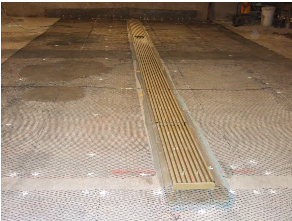
Figur 3.12 Keramisk avloppsränna i golv med katodiskt skydd med påtryck ström
