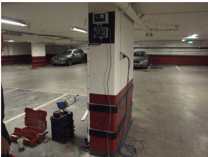
Figur 3.7 Likriktare med mätbox monterad på pelare C4
