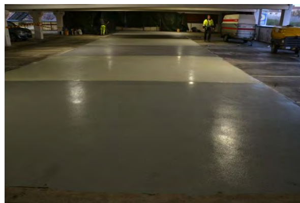
Figur 4.1 och 4.2 Färdig provläggning i Kvillegaraget (Foto: Y Edwards)
