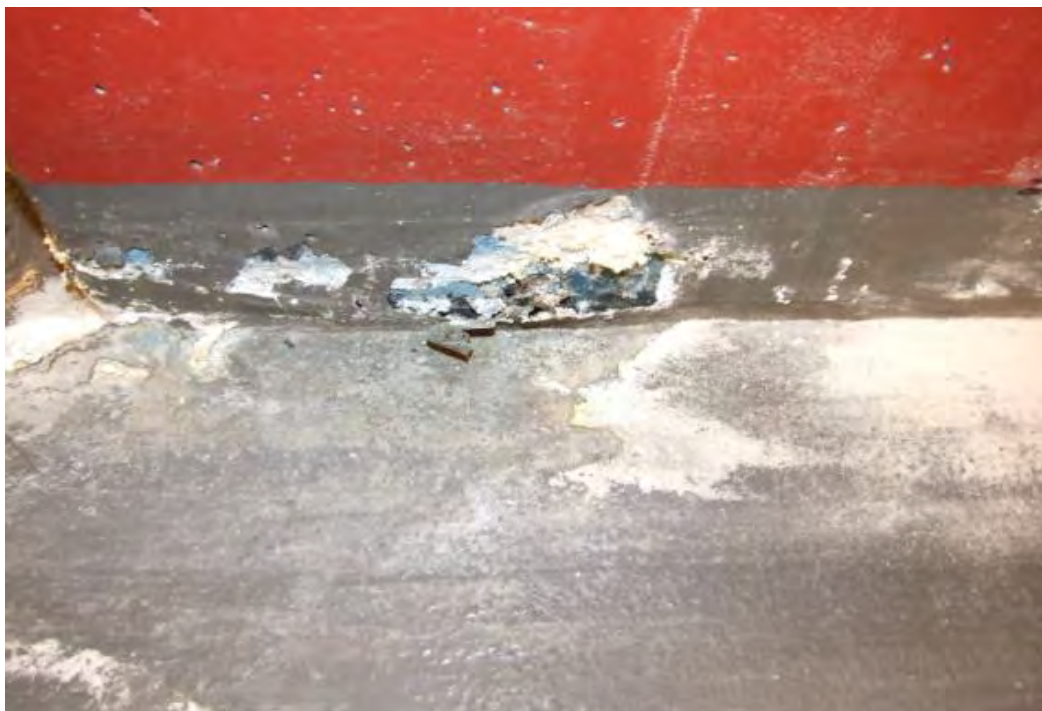
Figur 3.2 Betongskador på pelare C4 orsakat av armeringskorrosion
