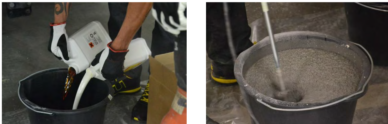
Figur 2.24 De två polyuretankomponenterna tillsätts (t v). Samtliga komponenter blandas (Foto: Y Edwards)
