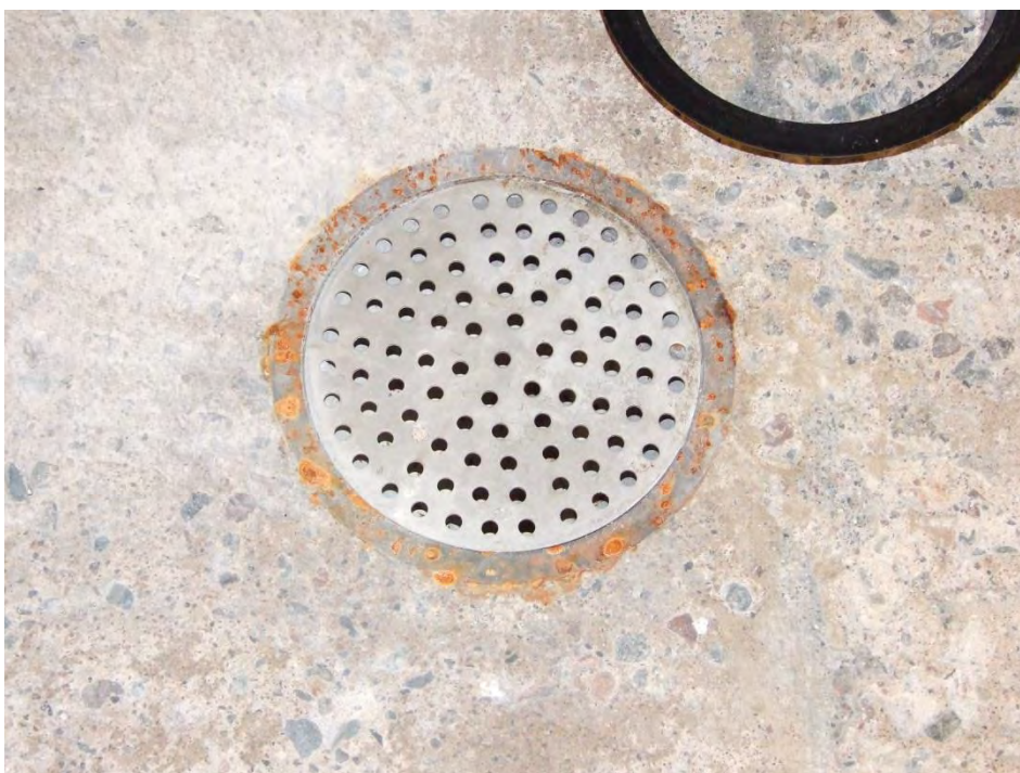
Figur 3.11 Avloppsbrunn som skall anslutas till armeringen
