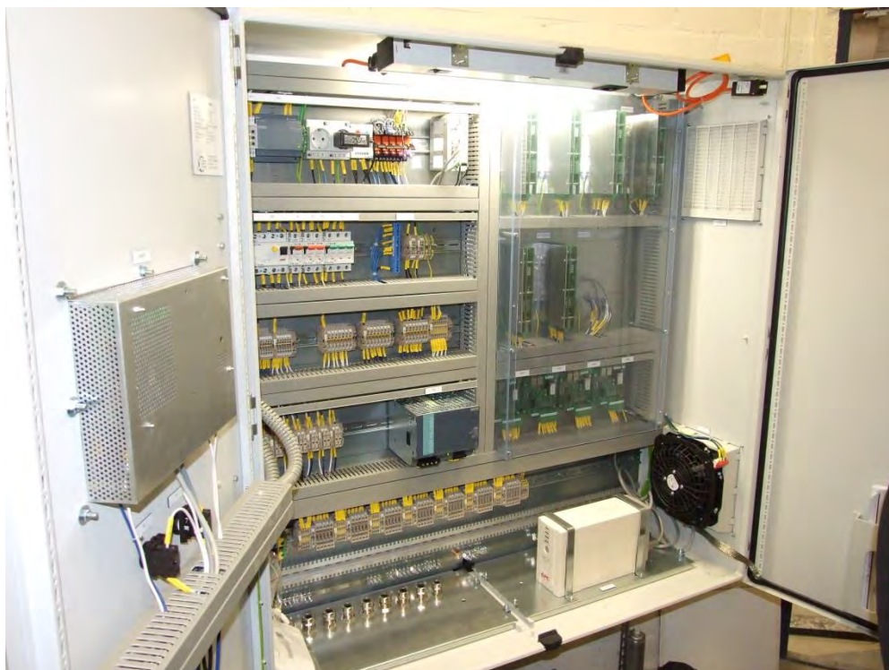
Figur 3 16 Apparatskåp för likriktare, övervakning och anslutningar av anodnät, armering och referenselektroder
