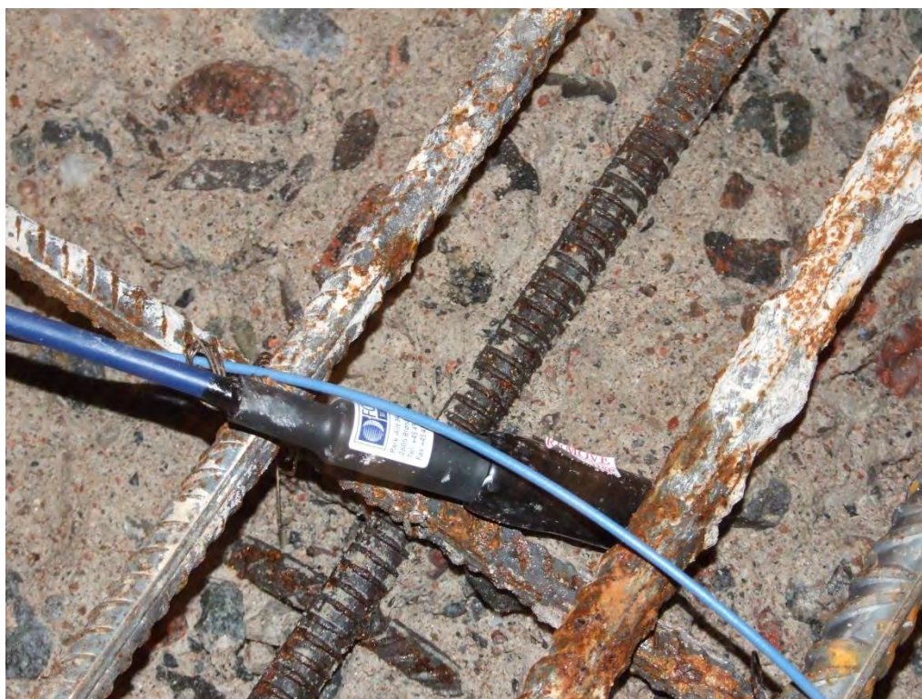
Figur 3.14 Montering av mangandioxid referenselektrod under armering
