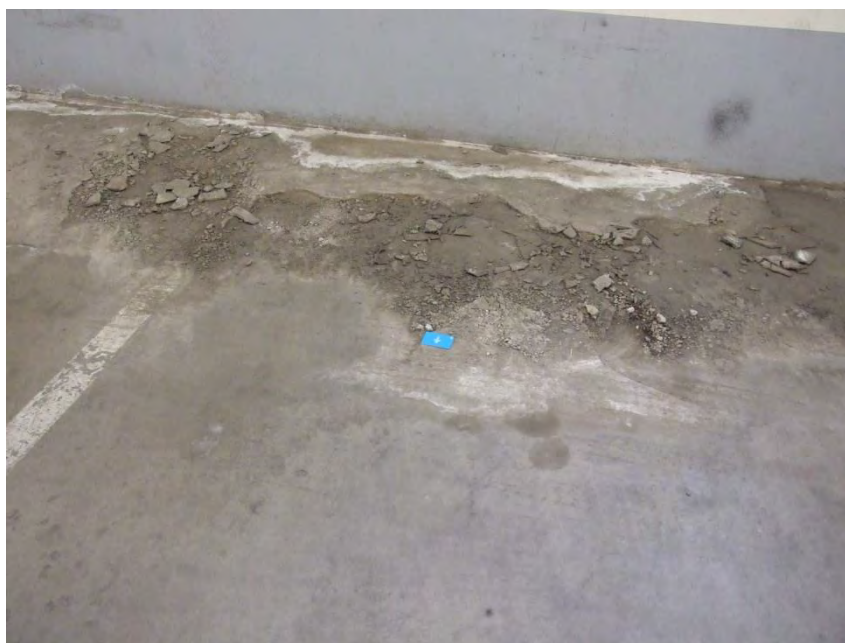
Figur 2.37 Spjälkad betong på grund av frostangrepp. Prov togs ut för kloridanalys (Foto: B. Sederholm)
