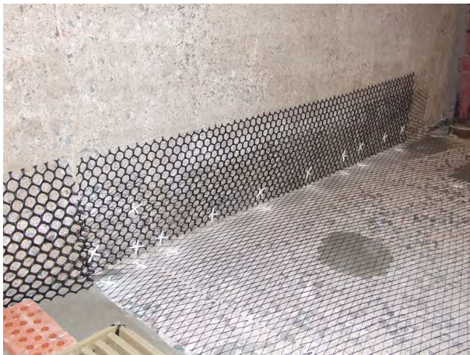
Figur 3.14 Fastmonterat plastnät som isolering mellan frilagd armering och anodnät
