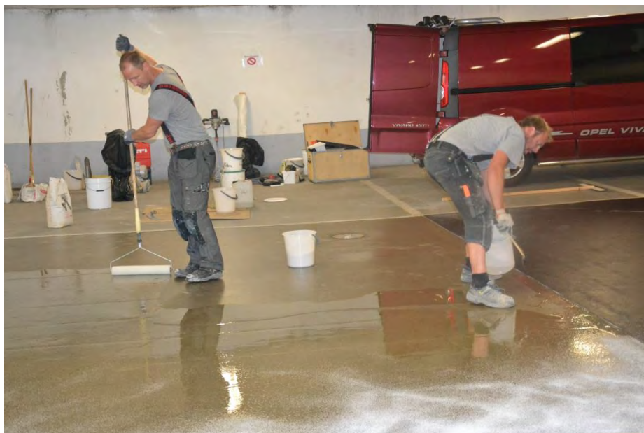
Figur 2.11 Primerlager nummer två påförs och ströas med grå kvartssand (Foto: Y Edwards)
