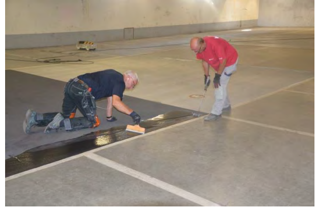
Figur 2.20 Ytterligare ett lager påförs och ströas (t v) samt topplackas (t h) (Foto: Y Edwards)
