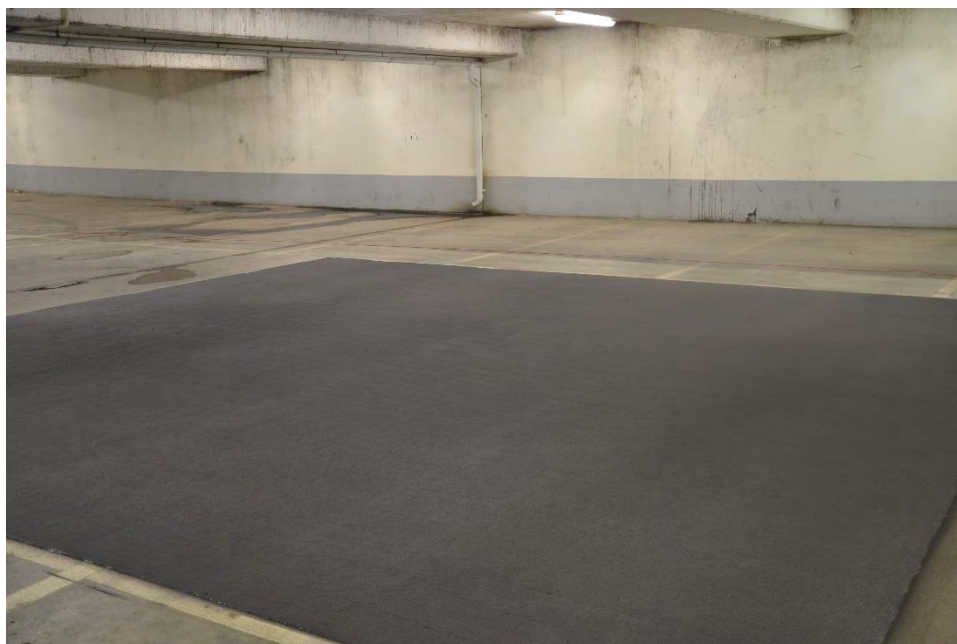
Figur 2.34 Färdig beläggning med Micorea S3 (svart) (Foto: Y Edwards)
