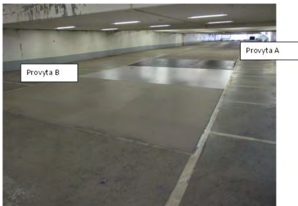
Figur 2.39 Placeringen av provytor där mätning av elektrokemisk potential har utförts (Foto: B. Sederholm)
