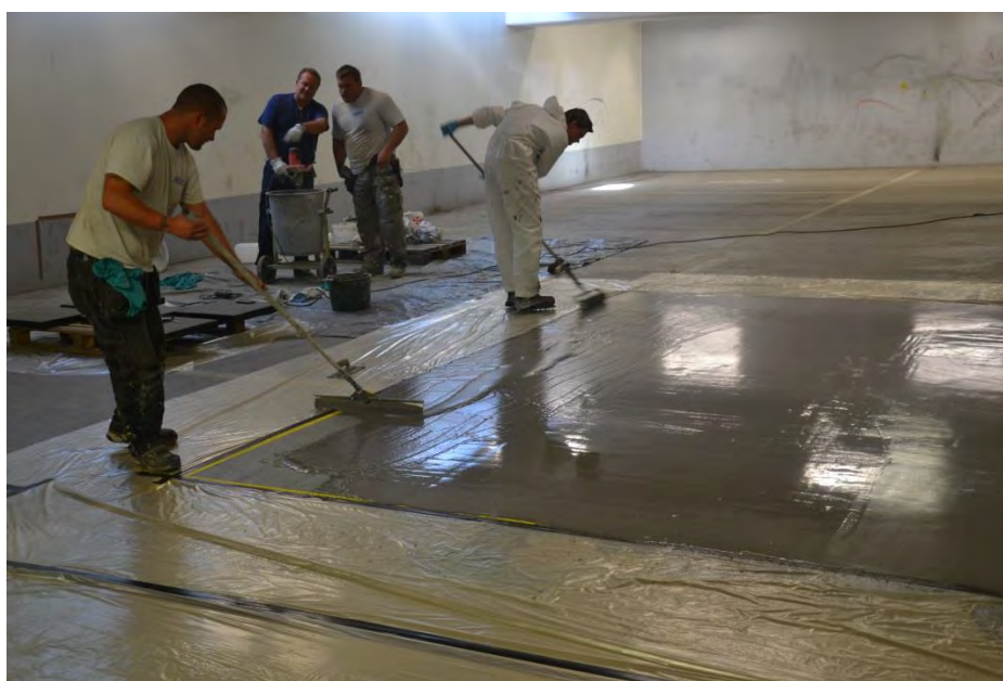
Figur 2.6 Utläggning av hårdbetong Intercrete 4852 (Foto: Y Edwards)
