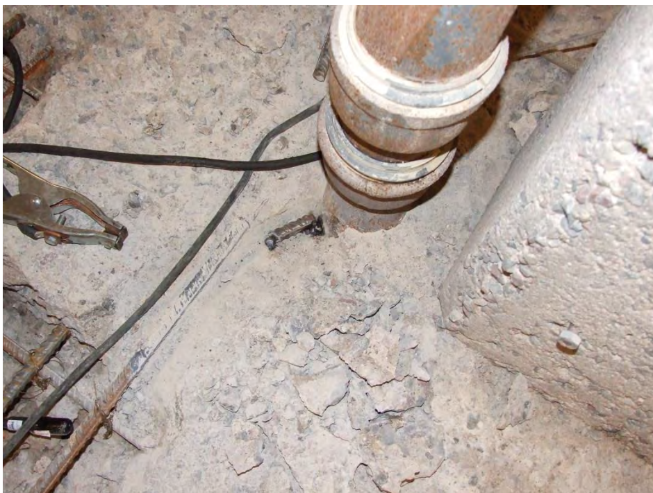
Figur 3.10 Gjutjärnsrör som skall anslutas till armeringen
