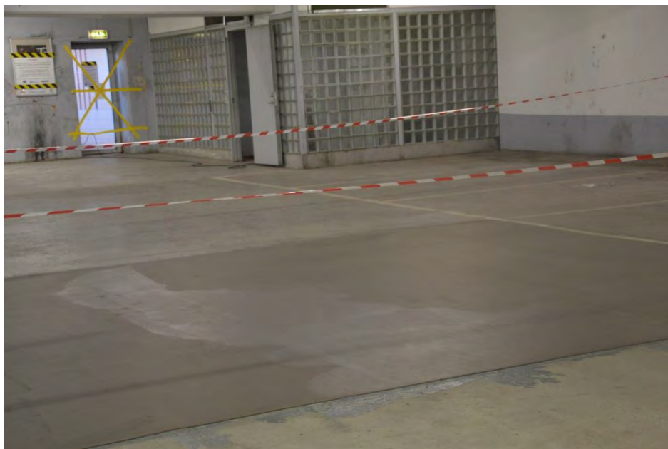
Figur 2.7 Färdig beläggningsyta. Nyansskillnaden i mitten av ytan beror på att en blandningsomgång genomförts med material från en tidigare batch (Foto: Y Edwards)
