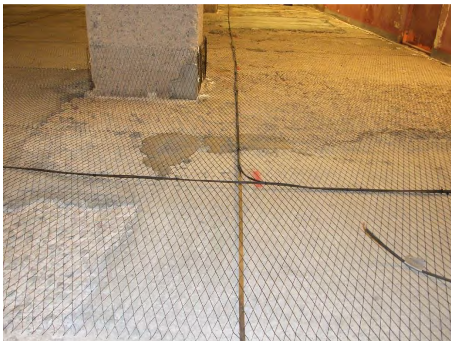
Figur 3.15 Anodnät som punktsvetsas ihop med ett strömfördelningsband av titan på pelare och golv
