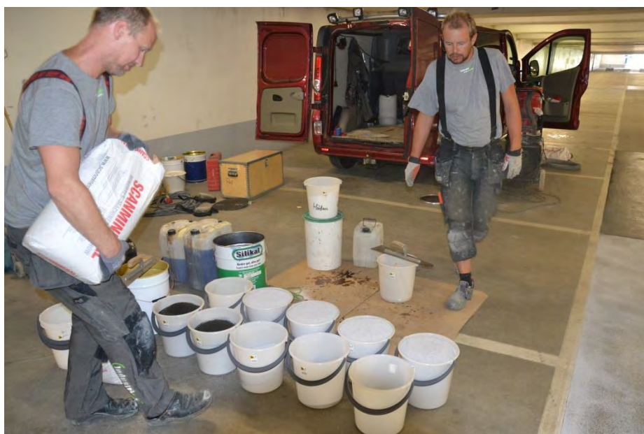
Figur 2.12 Sand med olika färg portioneras ut inför blandningen av Silikatmassan (Foto: Y Edwards)
