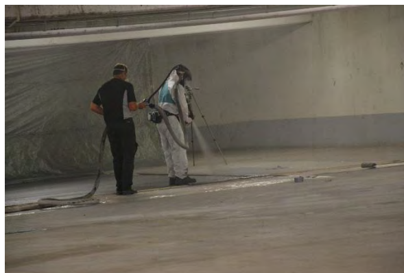
Figur 2.33 Sprutapplicering av polyurea genomförs (Foto: Y Edwards)
