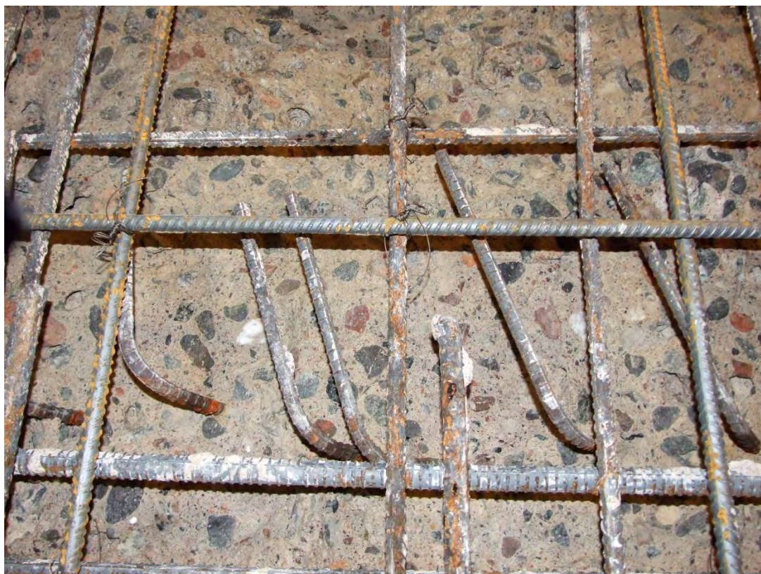
Figur 3.9 Korroderad najtråd som lossnat vid vattenbilning
