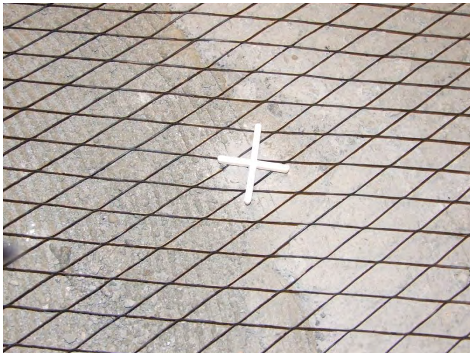
Figur 3-16 Anodnät fastmonterat med plastclips
