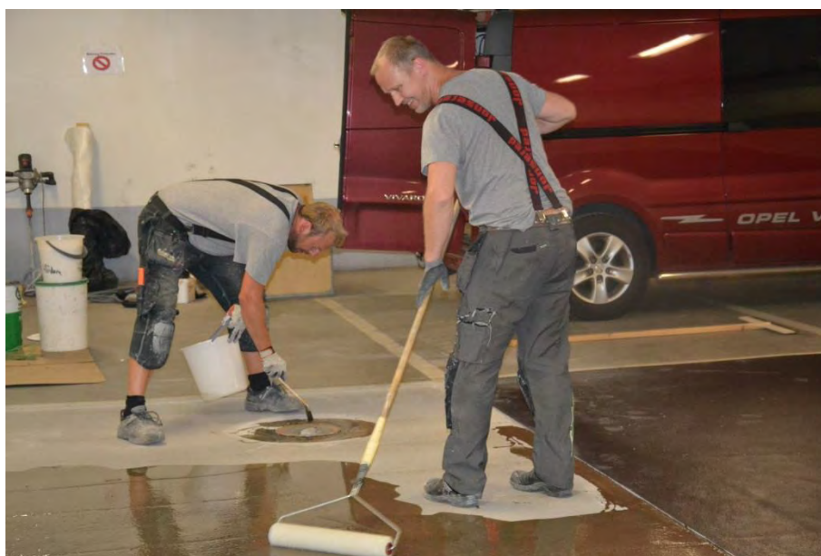
Figur 2.10 Första primerlagret påförs (Foto: Y Edwards)
