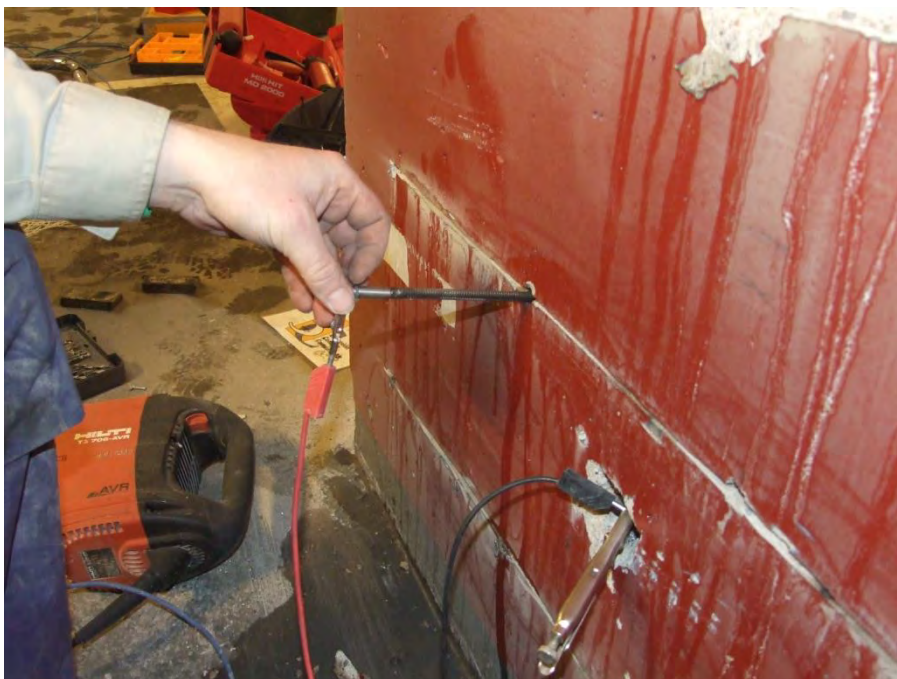
Figur 3.6 Montering av insticksanoder av märket DurAnod 3 i pelare C3
