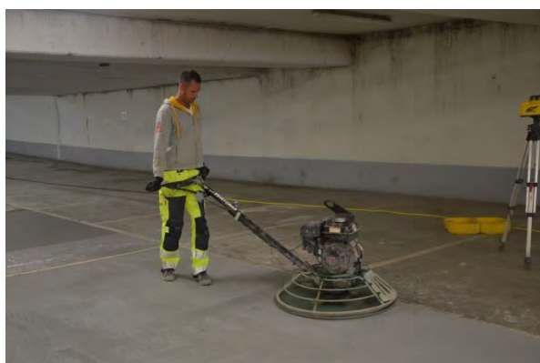
Figur 2.31 Mastertop brädrivs (t v). Färdig beläggning med membranhärdare (t h) (Foto: Y Edwards)
