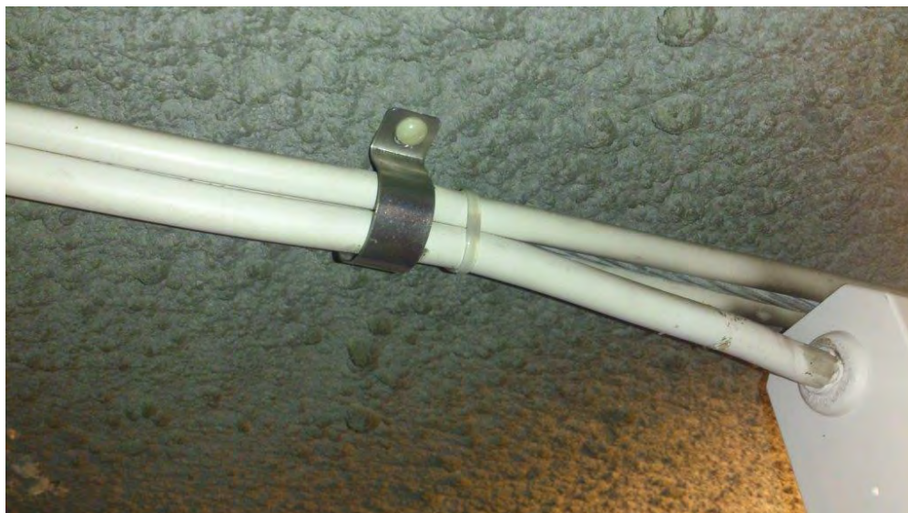
Figur 3.18 Elkablar fastmonterade med elskruvar som troligtvis är i kontakt med anodnät och armering
