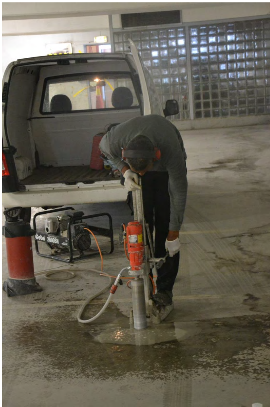
Figur 2.38 Provtagning av borrhärnor för undersökning av tryckhållfasthet, relativ fuktighet, kloridhalt, karbonatisering och potentialmätningar (Foto: Y Edwards)
