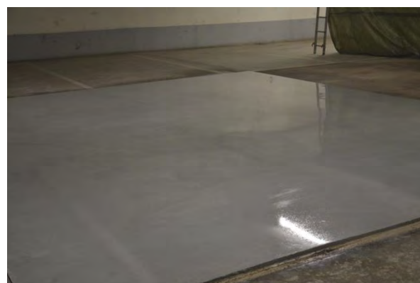
Figur 2.31 Mastertop brädrivs (t v). Färdig beläggning med membranhärdare (t h) (Foto: Y Edwards)
