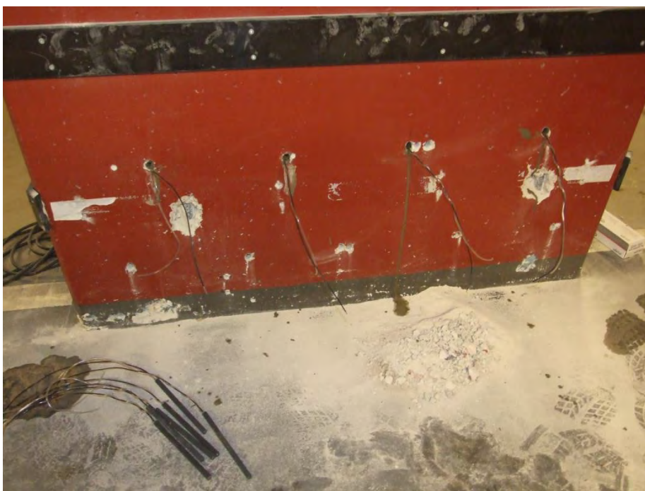
Figur 3.5 Pelare C4 med inmonterade insticksanoder av märket Ebonex Plus
